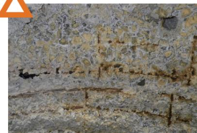
腐食ランクA(鉄筋露出)
