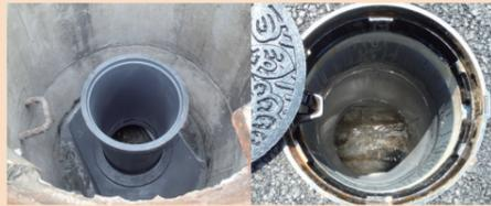
小型レジンマンホールを人孔内に設置する改築工法
