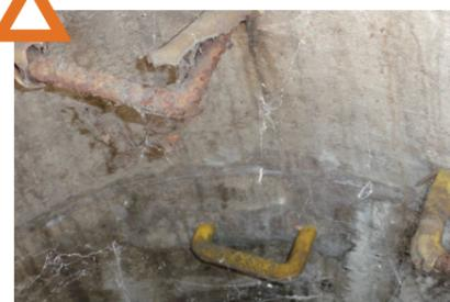
樹脂被覆が破損し、芯材腐食の可能性あり
