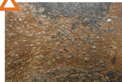
腐食ランクB(骨材露出)
