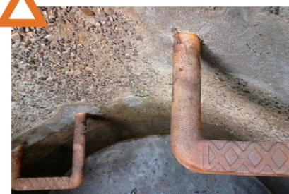
取り付けしているコンクリート部分が劣化しており、ステップも劣化の可能性あり
