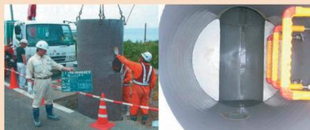
更生材として二次製品を人孔内に挿入する自立工法
